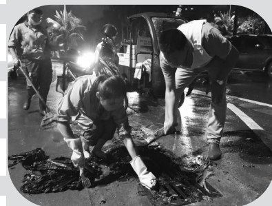
环卫工人用手清理排水口杂物
