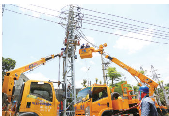
电力工人高温作业(杨永光摄)
