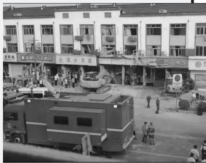
▲附近商铺受到爆炸波及,墙体、玻璃、窗框等被损坏
