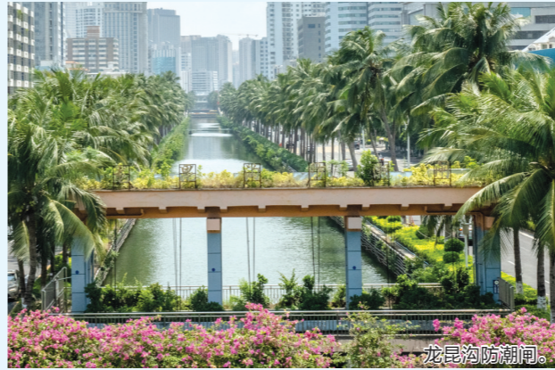
龙昆沟防冲闸。
